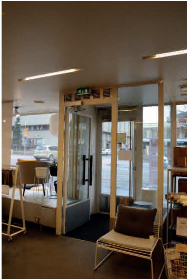
78. Pitkään tiloissa toiminut Spazio Oy on antanut kohteelle tunnistettavan identiteetin. Tuulikaappi ja sen väliovi ovat alkuperäispiirustusten mukaiset. Näyteikkuna avautuu laajasti eri suuntiin.
