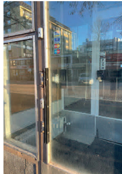
51. Lankavetimien viivamaisuus on alkuperäisintentioiden mukainen. Viivamainen kahva erottuu julkisivussa muusta julkisivusta poikkeavan värinsä ansiosta, mikä havaitaan kadulla kulkiessa. Edestäpäin kahva katoaa osaksi viivojen kokonaisuutta julkisivussa. Kulkusuunnat on eroteltu ja sisällä on käytetty työntölevyä.
