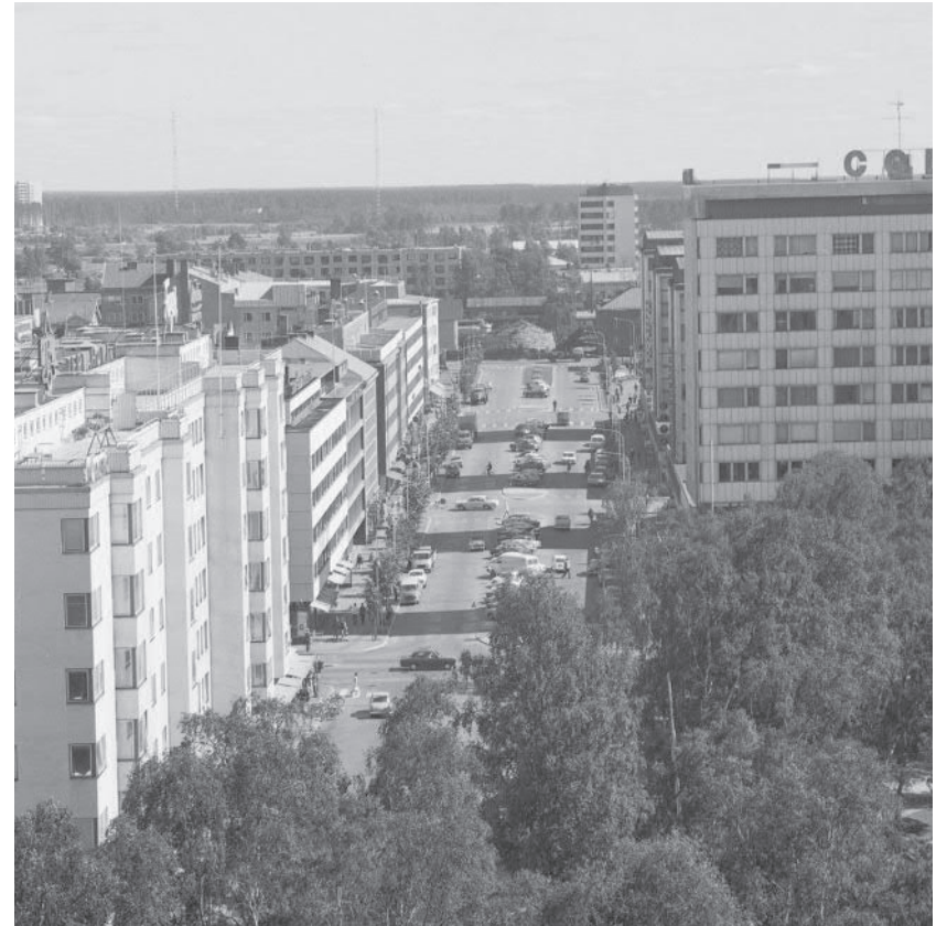
13. Näkymä Hallituskadulta puutalojen purun jälkeen. Visakauma Oy on ollut looginen jatke Hallituskadun katkeamattomana jatkuville pohjoisjulkisivuille. Rakennus on päättänyt Hallituskadulla aloitetun muutoksen. KUVA: Kanerva, Teuvo. Museovirasto.
