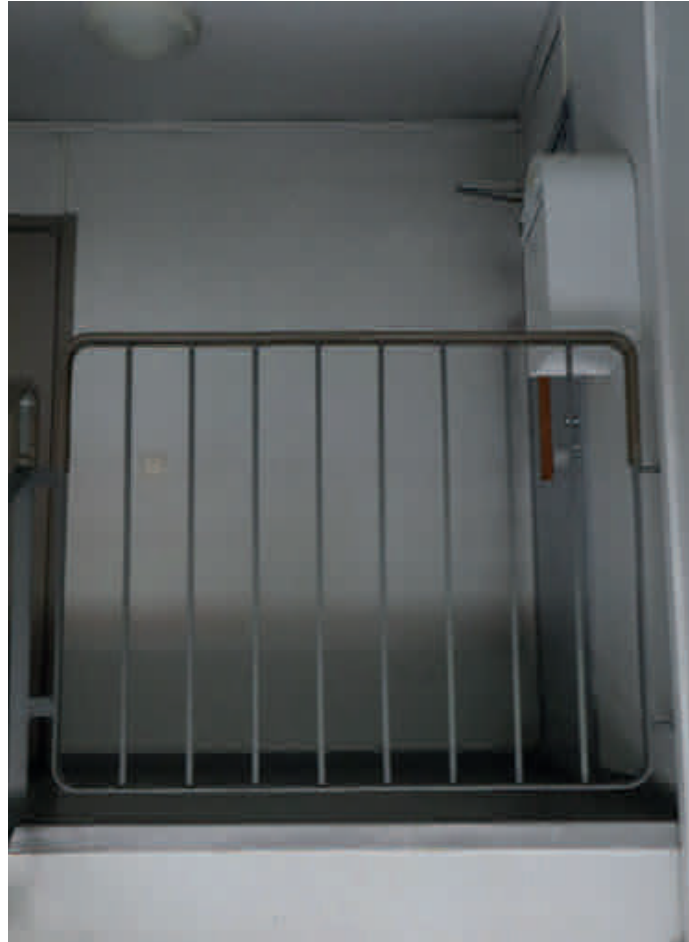
97. Portaat ovat mosaiikkipintaisia A-elementtejä ja kaiteet teräsrakenteisia muovipäällysteisin käsijohtein.
