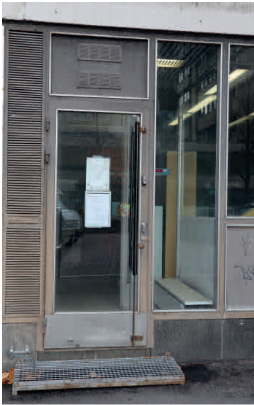
47. Sisäänkäyntiympäristöissä on havaittavissa muutoksia, mutta myös alkuperäisiä intentioita on havaittavissa. Esimerkiksi lankavetimiä on säilynyt osissa ovia. Ikkunoiden sirot listat ovat vaihtuneet paikoin leveämpiin eri henkisiin listoihin. Uudistuneissa ovissa detaljien määrä on lisääntynyt. Säilyneimmässä oviympäristössä havaitaan kokonaisuuden yhteneväisyys.
