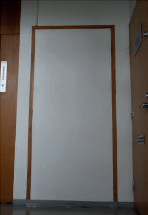
101. Takana olevien huoneistojakojen muuttuessa käytöstä poistuneet ovet on levytetty umpeen.
