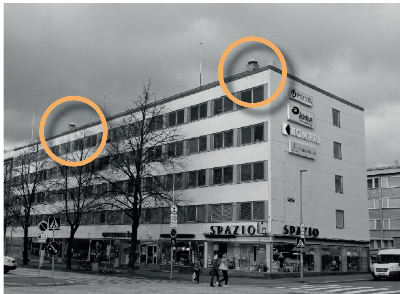
32. Ilmanvaihtokanavat muodostavat aiheen kohteen askeettisessa ulkoarkkitehtuurissa. Suunnittelija on ollut tästä tietoinen ja halunnut tarkastella vaihtoehtoja. Tämä käy ilmi eri osapiirustuksista.
