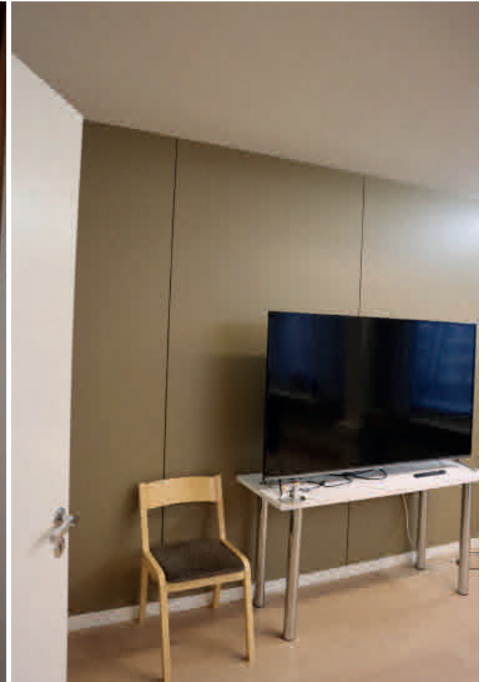
124. Levyjen väliset avosaummat ovat säilyneet paikoin.
