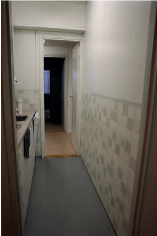
122. Keittokomero on säilynyt alkuperäisellä paikallaan. Laatat ja kalusteet poikeavat alkuperäisestä.
