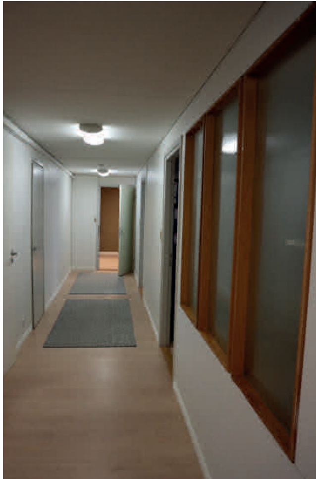
123. Konttorien ja käytävän välisiä alkuperäisiä ikkunoita on säilynyt. Tammilistojen syvyysprofiili on oleellinen aihe. Lasituksissa on tapahtunut muutoksia. Lattioiden koristelistat ja uudet materiaalit edustavat erilaista tyyli-ihannetta.
