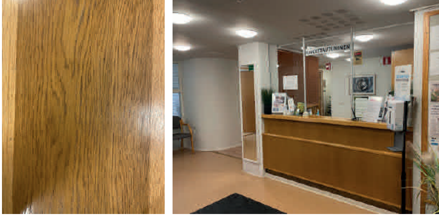
111. Jalopuinen vastaanottotiski eroaa 80-luvun piirustuksiin piiretystä muodosta, mutta tiski on säilynyt piirustusten mukaisella paikalla.
