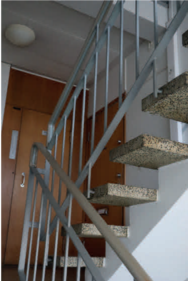
97. Portaat ovat mosaiikkipintaisia A-elementtejä ja kaiteet teräsrakenteisia muovipäällysteisin käsijohtein.
