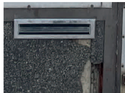
52. Vanha postiluukku on osa julkisivujärjestelmää. Uudempi on asennettu erillisenä asennuksena pesubetonipintaan. Intentiot poikkeavat toisistaan.
