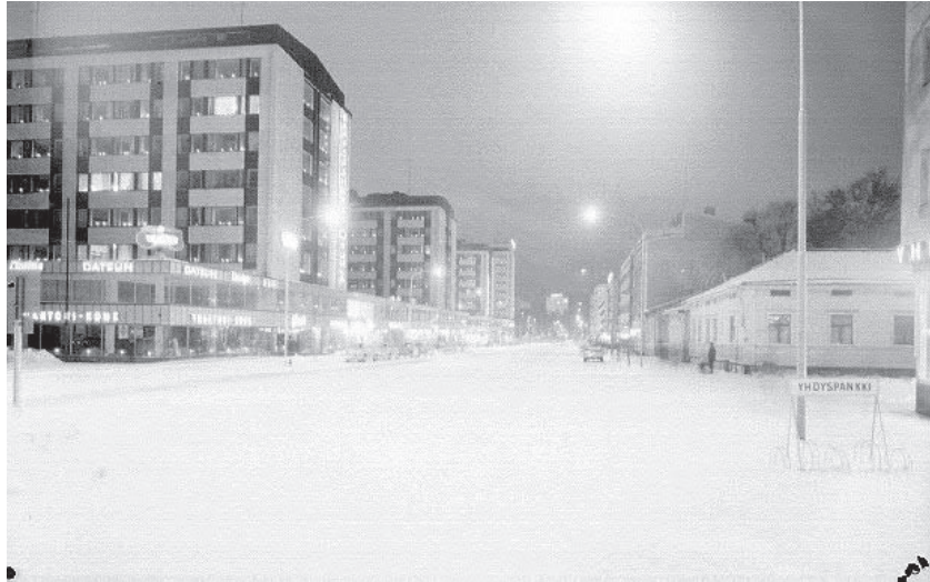
7. Viimeiset puutalot kerrostalokortteleiden keskellä. Kuva: Uuno Laukka, Pohjois-Pohjanmaan museo.
