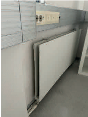
70. Teräslevypatterit ovat alkuperäisiä ja istuvat sisustusratkaisuihin. Sähkökotelot on uusittu eri tarpeeseen.
