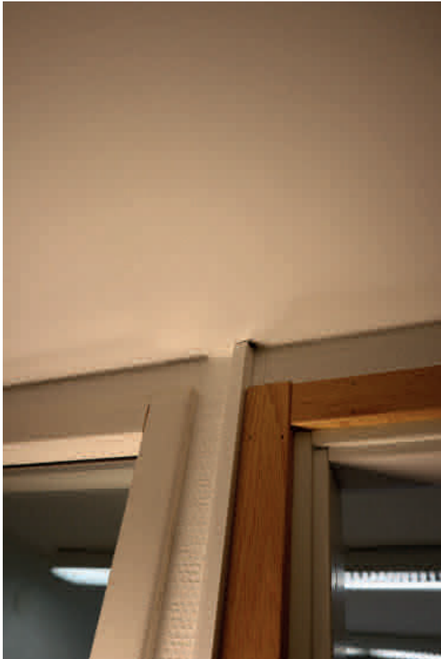
114. Listoitusten liitokset poikkeavat alkuperäisistä 60-luvun jiiiriin sahatuista liitoksista. 80-luvun muutoksissa on suosittu kuvan liitostyyppiä.
