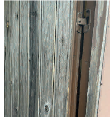
153. Alkuperäiset ovet vesikatolle ovat patinoituneet sään vaikutuksesta. Ne erottuvat myös ulkoarkkitehtuurissa kadun toiselta puolelta.
