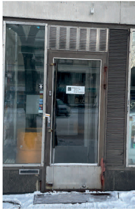
47. Sisäänkäyntiympäristöissä on havaittavissa muutoksia, mutta myös alkuperäisiä intentioita on havaittavissa. Esimerkiksi lankavetimiä on säilynyt osissa ovia. Ikkunoiden sirot listat ovat vaihtuneet paikoin leveämpiin eri henkisiin listoihin. Uudistuneissa ovissa detaljien määrä on lisääntynyt. Säilyneimmässä oviympäristössä havaitaan kokonaisuuden yhteneväisyys.
