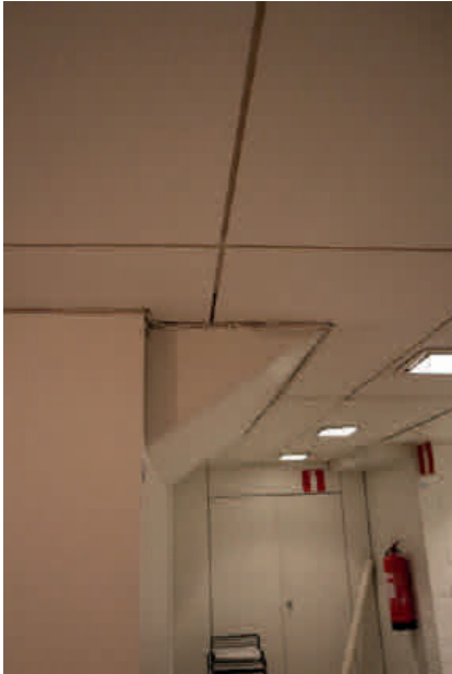
82. Portaat ovat levytettynä umpeen. Kellarin portaat ovat pääosin paikallavalettuja.
