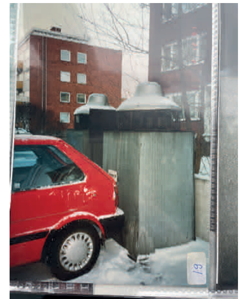
33. Ilmanvaihtokanavat on uusittu nykyisillä tuotteilla. Ratkaisu eroaa kohteen materiaali- ja detailjamaailmasta. KUVA oik.: Visakauma Oy taloyhtiön arkisto.
