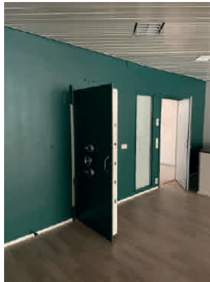
67. Kassaholvi on säilynyt muuttuneessa ympäristössä samoin takatilojen seinälinja. Holvin viereisessä tilassa on alunperin ollut pankinjohtajan tilat. Alkuperäiset jalopuumateriaalit ovat kadonneet.
