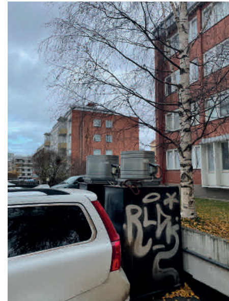
33. Ilmanvaihtokanavat on uusittu nykyisillä tuotteilla. Ratkaisu eroaa kohteen materiaali- ja detailjamaailmasta. KUVA oik.: Visakauma Oy taloyhtiön arkisto.
