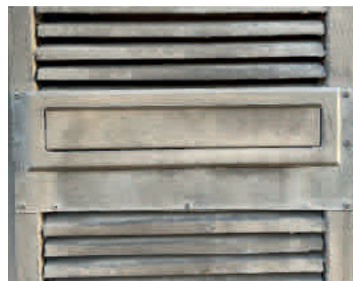
52. Vanha postiluukku on osa julkisivujärjestelmää. Uudempi on asennettu erillisenä asennuksena pesubetonipintaan. Intentiot poikkeavat toisistaan.
